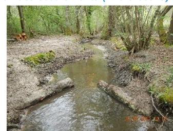
Fixation d'embâcle pour diversifier les écoulements (source : SEBB)
