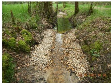
Recharge en granulat dans le lit d'un cours d'eau (source : SEBB)
